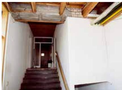
Umbau Kindergarten Sonnenstraße
